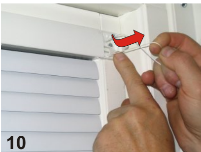
10 Håll lina med ena handen och öppna låslocket. Dra i lina tills den är sträckt. Gör lika på andra sidan. Håll i båda linorna och dra tills det tar stopp, först till vänster och sedan till höger. Dra sedan till vänster igen men endast 2/3 av sträckan (fjädrer ligger nu mitt emellan lagerbockarna). Lås vänster lina med låslocket. Spänn sedan fjädrer genom att dra i höger lina så att persiennen stannar i valt läge. Vid 4st linor skall yttre linor spännas först och hårdast. Inre linor är kopplade till separata fjädrar och spänns var för sig utan att underlisten bågner.
