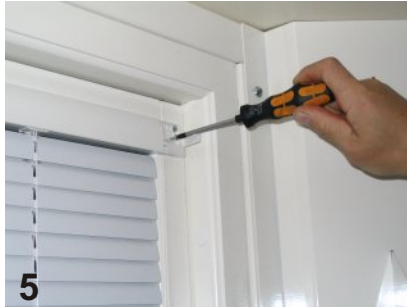
5 Skruva för hand fast persiennen/plissén med de medföljande skruvarna.
