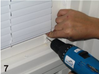
7 Förborra för en skruv i varje fäste.
