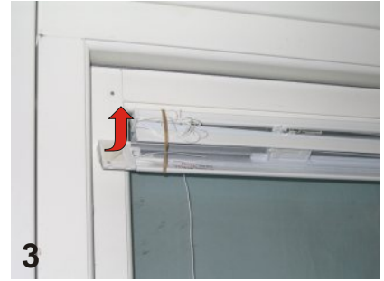
3 Linda av upprullade linor från persiennen/plissén Ta bort täckåpor på överlistens ändar genom att lossa i överkant först. Dra bort skyddsfilm på den dubbelhäftade tejp i varje ände på persiennen/plissén
