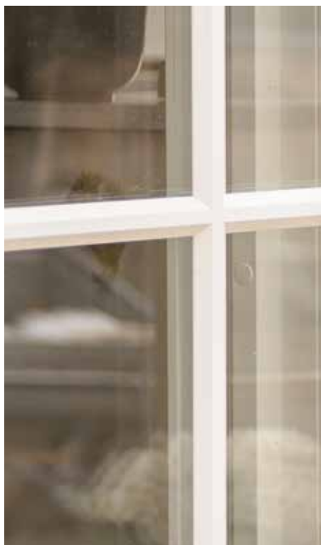
Exempel utanpåliggande spröjs.
