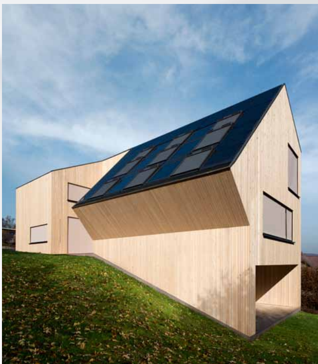
Sunlighthouse Uppfört i Österrike, 2010.
