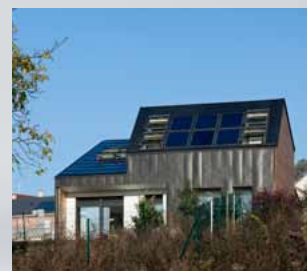
Maison Air et Lumière Uppfört i Frankrike, 2011.
