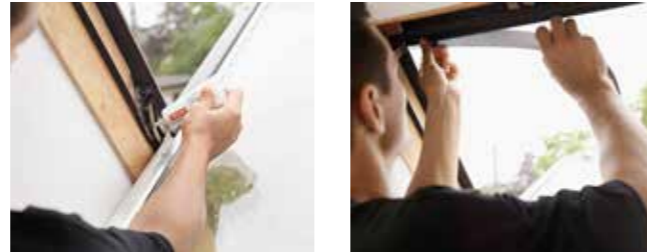
Underhåll låskista, gångjärnet och luftfiltret
